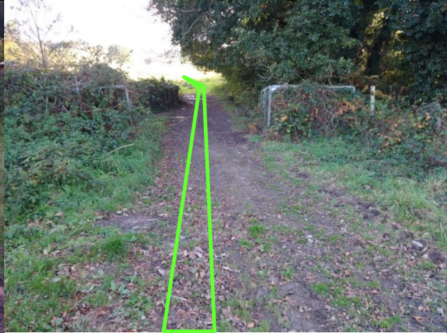
Photo 62 : Passage du ruisseau de Quillidien, au niveau du chemin agricole (passage du ruisseau sous le chemin dans une buse, vue vers le sud).
