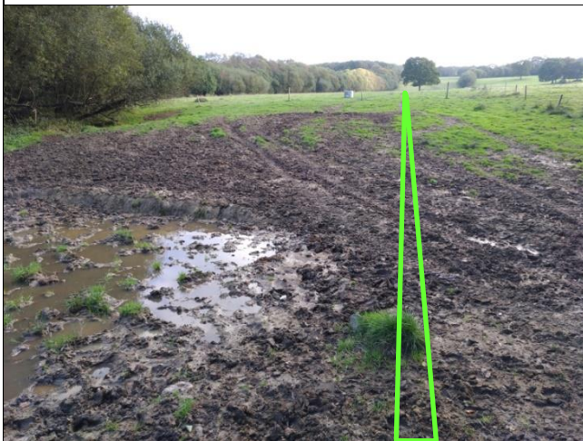
Photo 63 : Passage de la tranchée dans la zone humide au nord de K 1 (vue vers le sud, K 1 derrière l'arbre isolé au fond).
